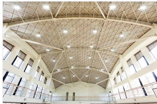
長岡第五小学校屋内運動場
