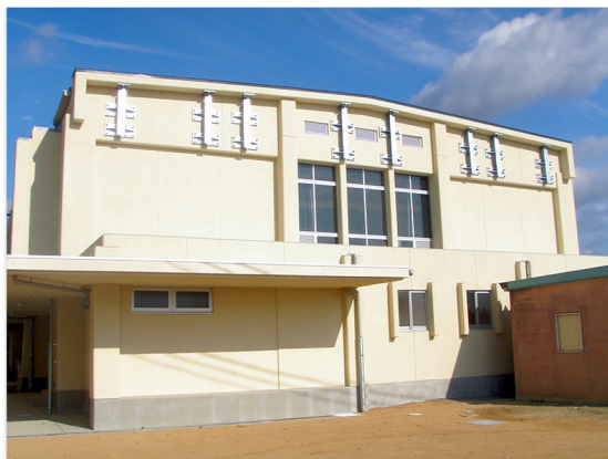
富野小学校屋内運動場
