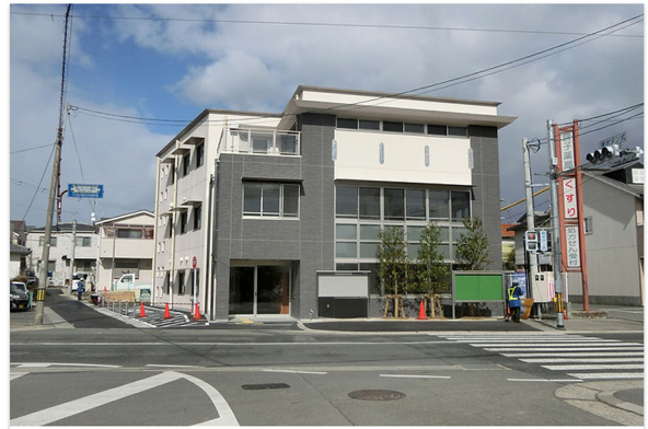
長岡京市南部地域防災センター
