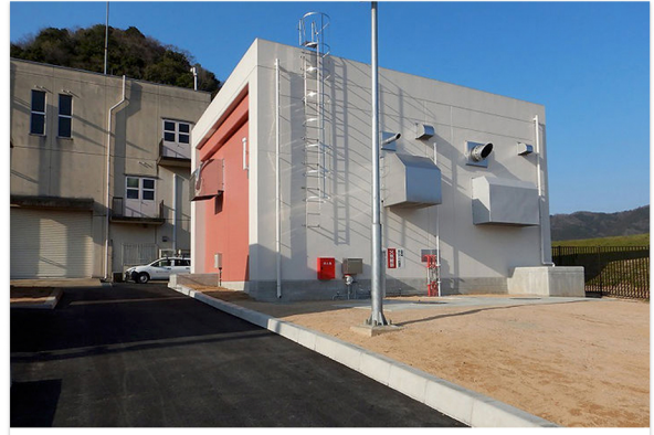
法川排水機場
