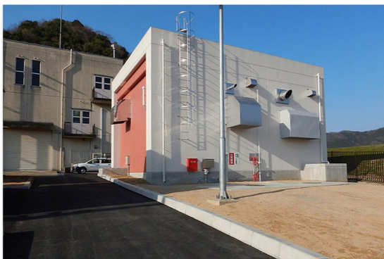
法川排水機場
