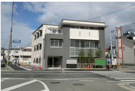
長岡京市南部地域防災センター
