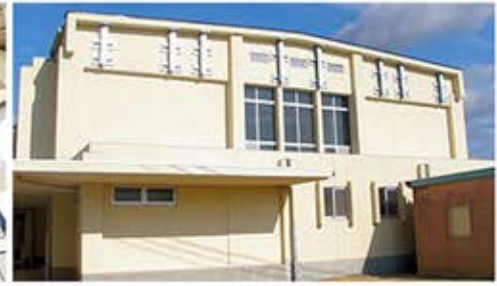
富野小学校屋内運動場
