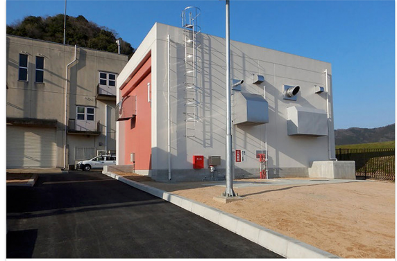
法川排水機場
