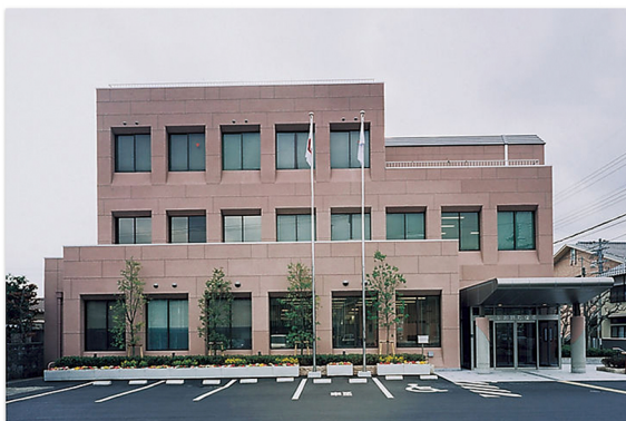
与謝野町本庁舎（改修）
