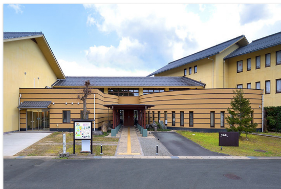
三和荘外観（改修）
