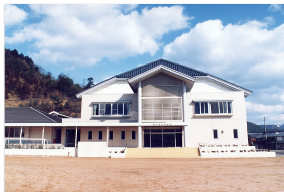
東小学校屋内体育館
