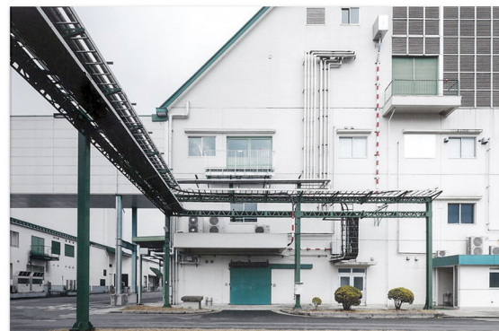
日本血液製剤3号棟改修
