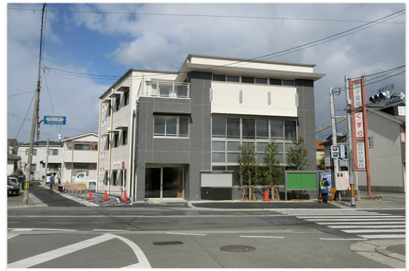
長岡京市南部地域防災センター
