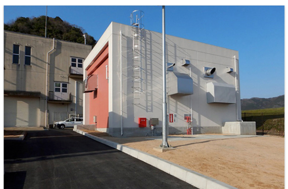
法川排水機場
