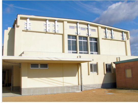
富野小学校屋内運動場
